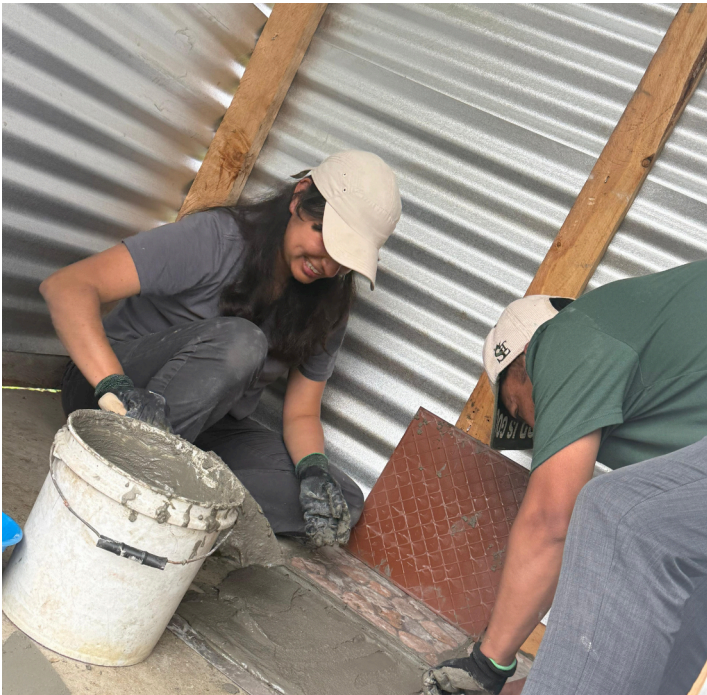
Manuel et Natalia qui mettent en place le parterre des toilettes sèches, à Nichen. Photo prise par Eleazar.
