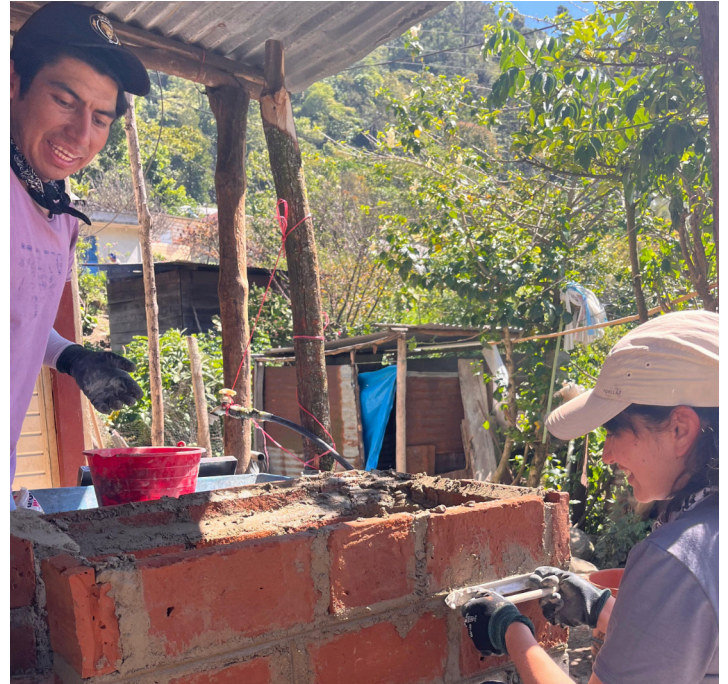
Elías et Natalia qui travaillent à la construction d'un foyer économiseur de bois, à Emiliano Zapata. Photo prise par Eleazar.
