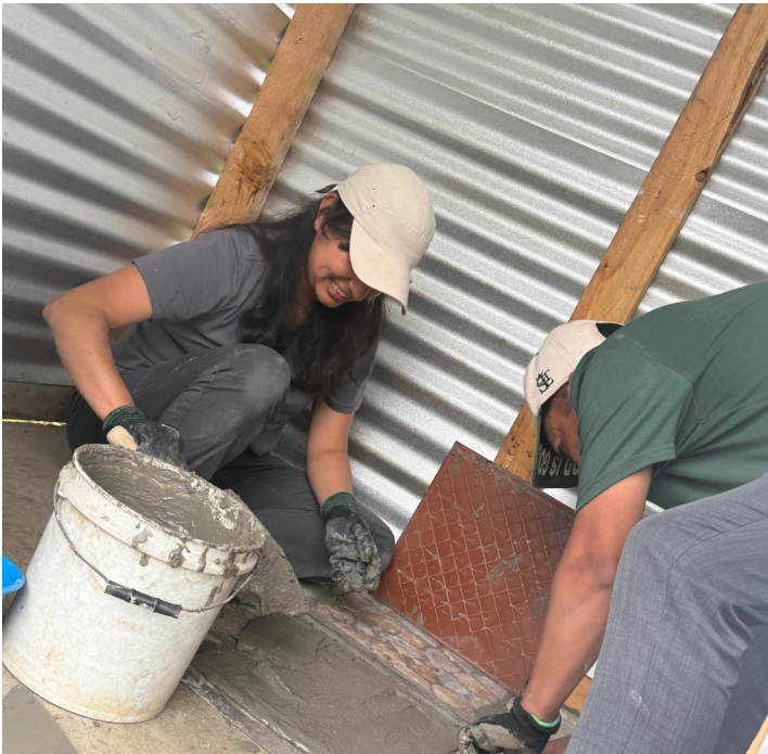
Manuel y Natalia instalando el de los baños secos, en Nichen. Foto tomada por Eleazar.
