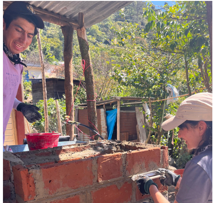
Elías y Natalia trabajando en la construcción de una estufa ahorradora de leña, en Emiliano Zapata. Foto tomada por Eleazar.
