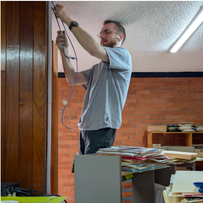
Rénovation de l'infrastructure réseau de la bibliothèque de la CTM
