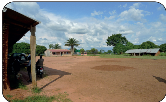
Des anciens bâtiments de la station de mission de Kinkuni.
