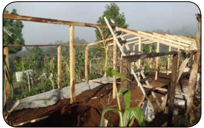
Serre en construction à San Isidro.
