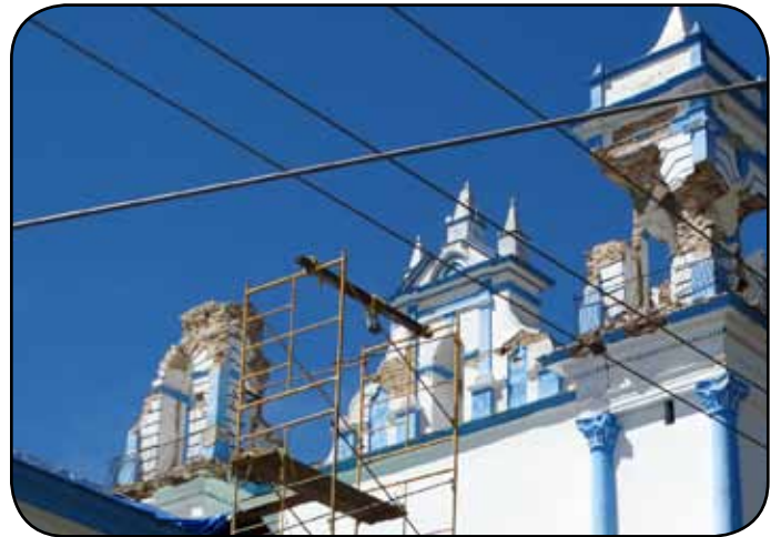
Eglise Santa Lucia endommagée par le tremblement de terre à Sant Cristóbal de las Casas.
