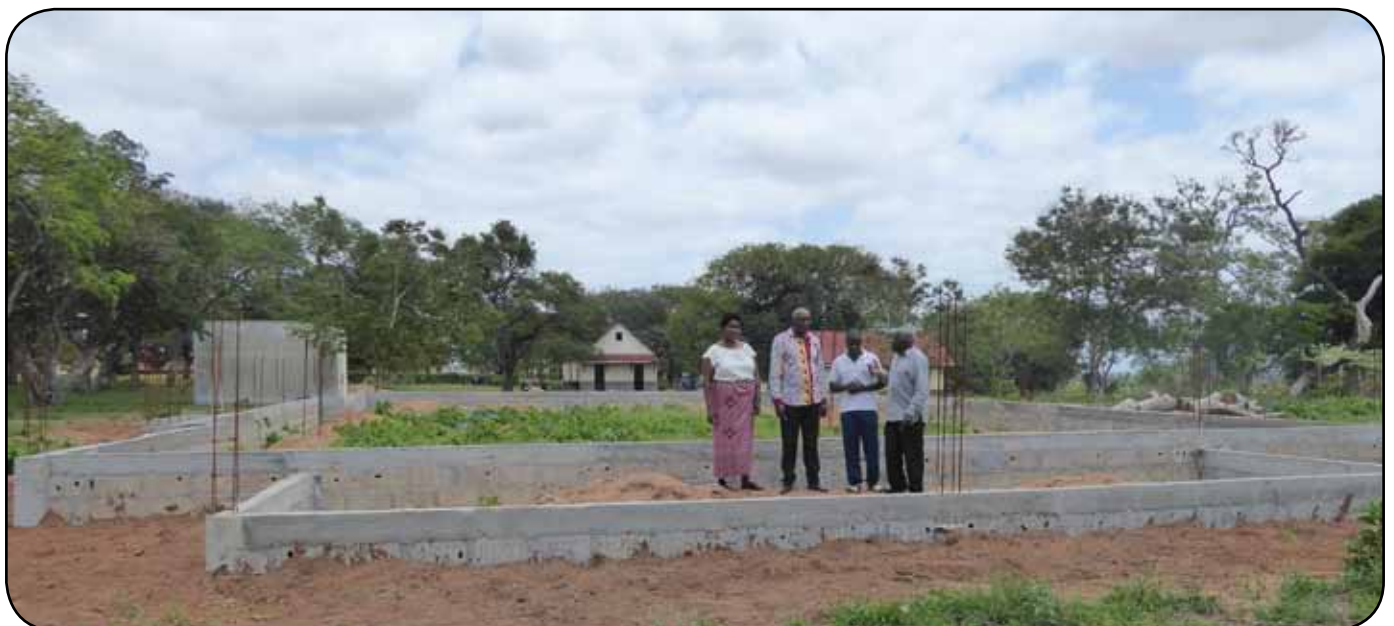
Devant l'ancienne chapelle, les fondations de la nouvelle.
