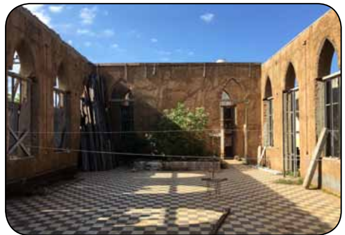
L'église de Remedios sans toit.
