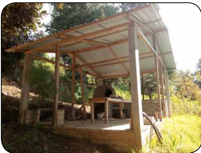
Dans le « cerro » de Huitepec, l'INESIN a construit un four lors d'un atelier. Plusieurs fours ont été construits dans des communautés.
