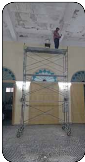
Angelito qui peint le plafond de l'église.
