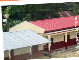
Rénovation de 5m 2 de toiture en tôle ondulée
